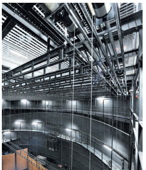
Les équipes latérales à câbles ECM AMG Féchoz sur cadre (en haut à droite)
