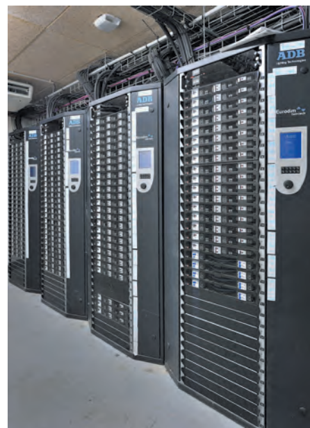
Armoires de gradateurs ADB Stand Alone Eurodim Twin Tech
