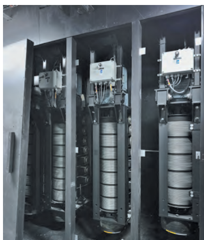
Motorisation des équipes de scène, treuils à trancannage verticaux AMG Féchoz et leurs caissons acoustiques
