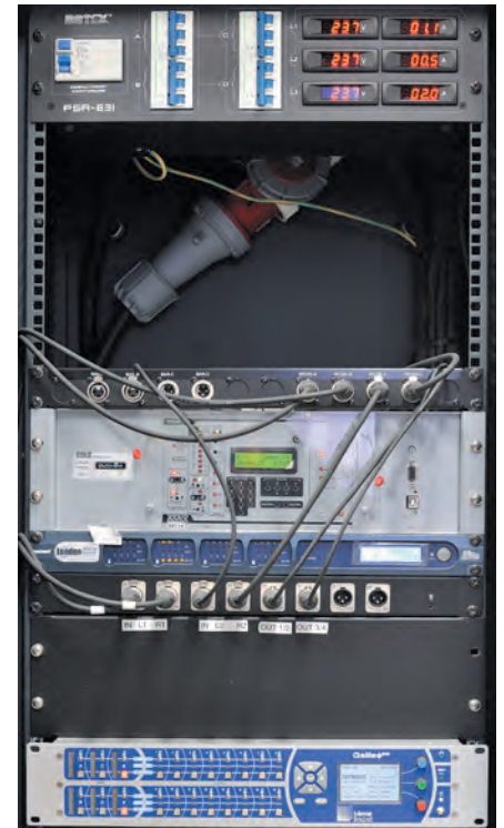
Armoire de gestion de la diffusion sonore, contrôleur Meyer Sound Galileo 616
