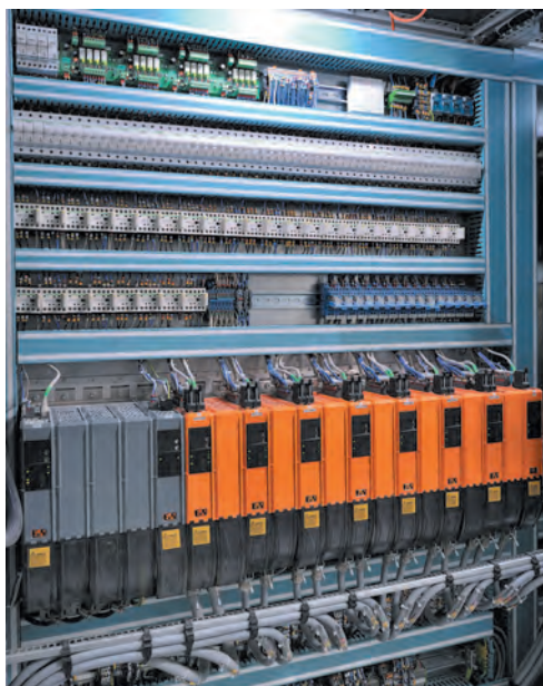
Armoire de machinerie AMG Féchoz, variateurs électroniques de vitesse, cartes d'axes
