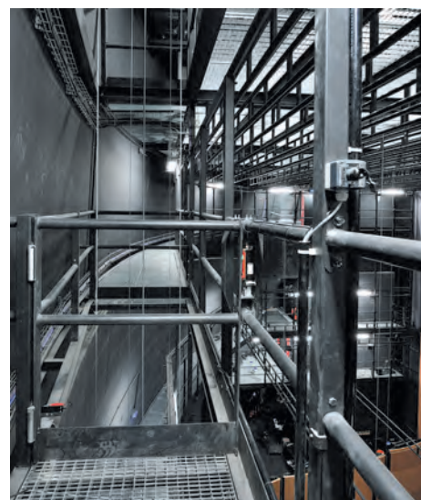
Passerelle 3 e service, interrompue par le monte-charge, passage autorisé en présence de la panier
