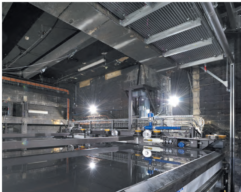
Garde-corps, trappe escamotable du plancher de salle, 3 plateaux mobiles : décor, liner, patinoire, piscine et ses promontoires télescopiques
