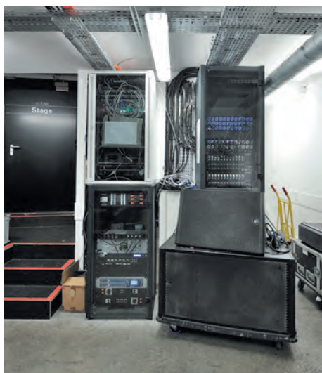
Local technique, enceinte Meyer Sound UPQ-1P posée sur un renfort de graves Meyer Sound 600-HP pour les retours
