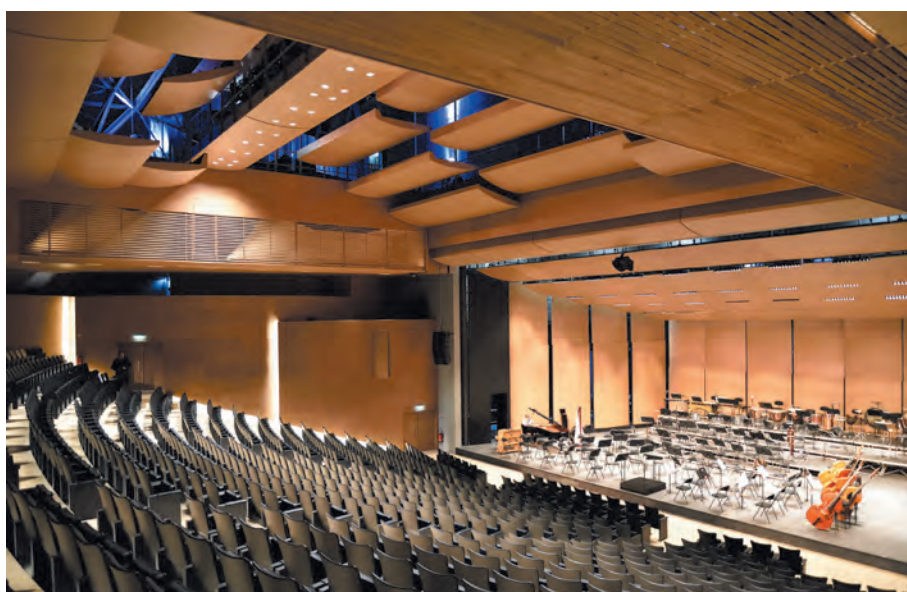
Configuration concert, plafond de salle ouvert + conque - Photo © Rémi Raskin
