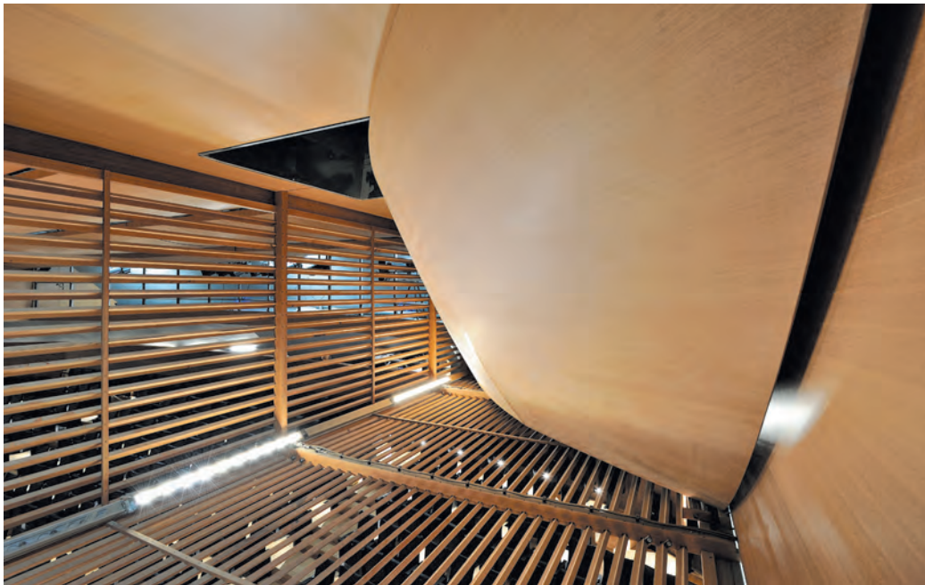
Grands réflecteurs acoustiques supérieurs refermés par des claustras, renvoi d'énergie au centre de la salle
