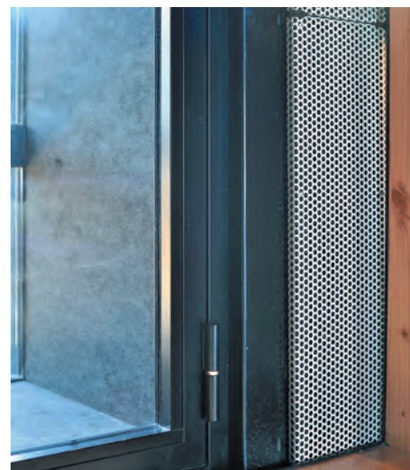
Epaisseur de 50 cm au niveau des doubles châssis vitrés
