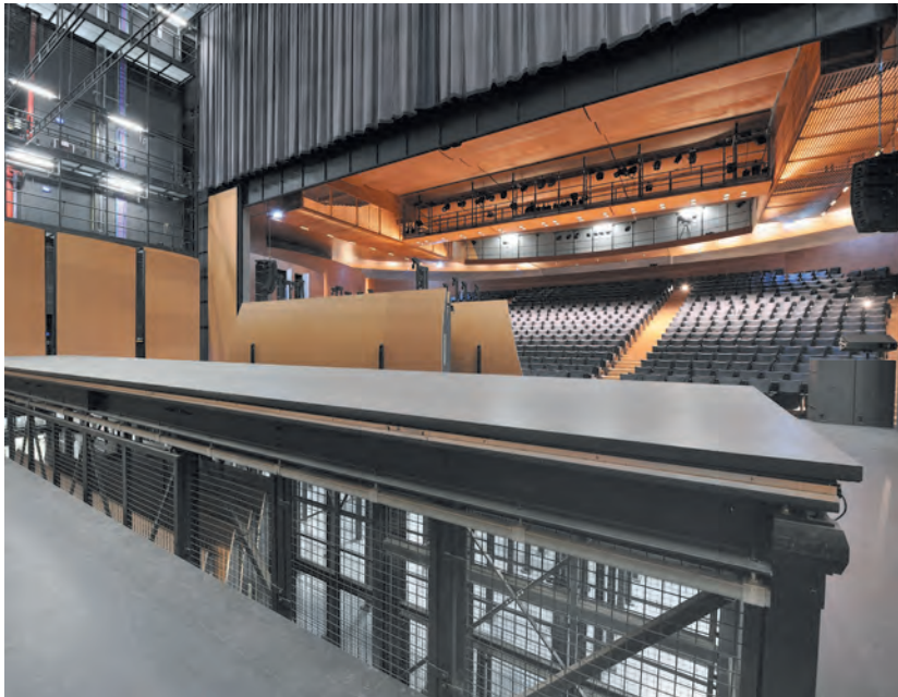
Élévateur de scène, palier intermédiaire à 1,20 m
