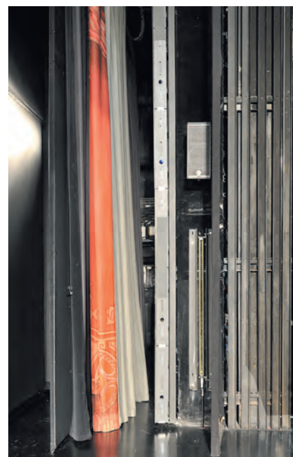
Cadre de l'arrière-scène : draperie, rideau, écran mobile à LEDs, rideau optique de sécurité, draperie, 5 glissières des décors volumétriques
