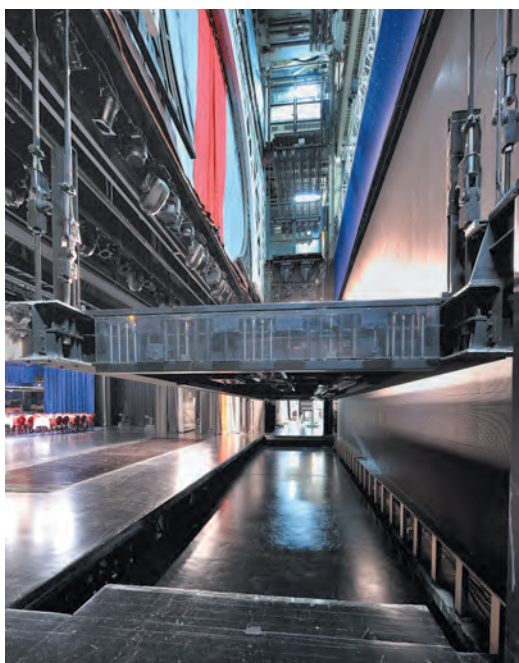
L'élévateur de l'arrière-scène haut 6 t. (monte décors) découvre les trappes de l'élévateur arrière-scène bas 16 t.
