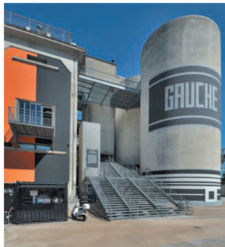
Accès public, conteneur billetterie (à gauche)
