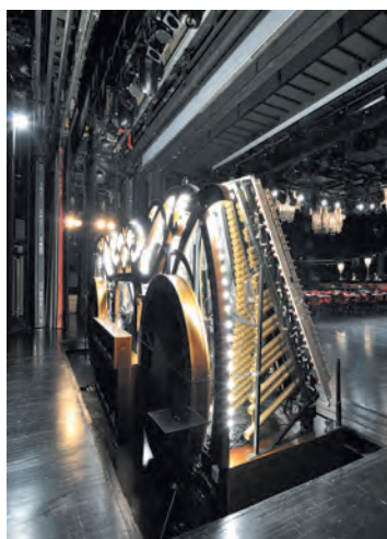
Orchestre mécanique en cours de sortie depuis les dessous de l'avant-scène
