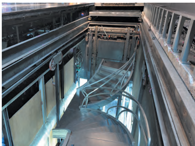
Élévateur arrière-scène bas 16 t, trappes ouvertes, le décor entame sa remontée depuis les dessous
