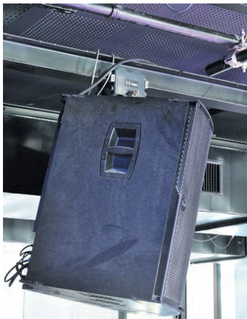
La diffusion ancrée sur chariot à galets coulissants en fonction de la taille de la scène
