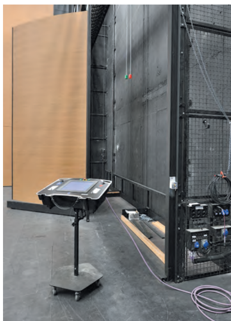
Pupitre de machinerie IAPI EasyScene
