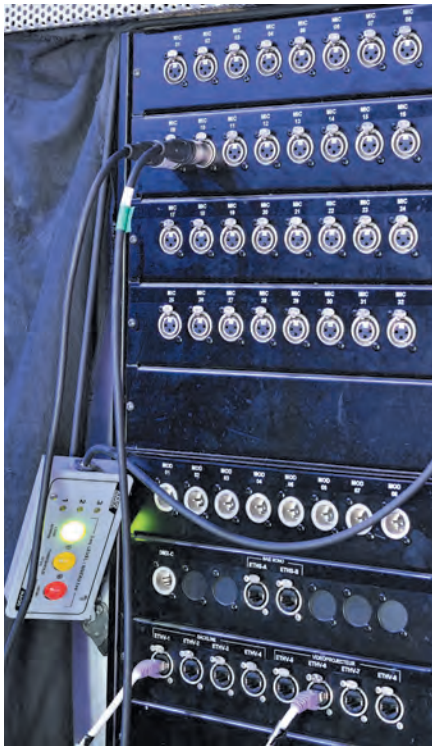
Patch avec entrées micros audio analogiques, line out et diffusion de contenus vidéo via liaisons numériques Neutrik etherCON RJ45
