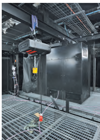
Poutre mobile équipée de son treuil ponctuel sur chariot transversal à galets, palan électrique ponctuel Liftket 1 t
