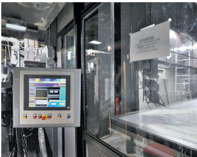
Poste de commande (l'autre étant sur scène), baie de sécurité interdisant l'accès des salariés pendant les manœuvres, patinoire en place
