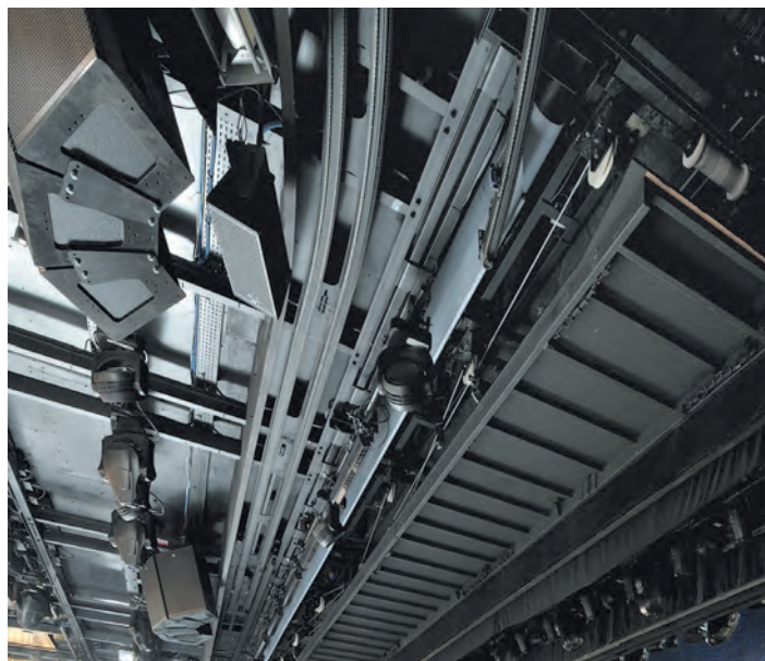
Faux grill du proscenium : diffusion sonore principale Meyer Sound, patiences motorisées Blackout, passerelle Baudin Chateaufort et cadre de scène
