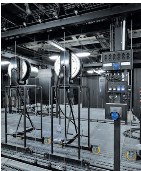
Gril de marche, réseaux scéniques, chaises guidées au sol et leurs enrouleurs de câbles Conductix Exel4
