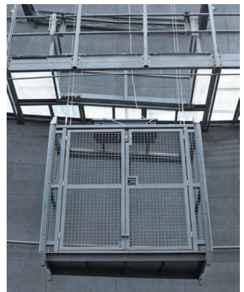
Panière du monte-charge desservant les passerelles et le gril de marche
