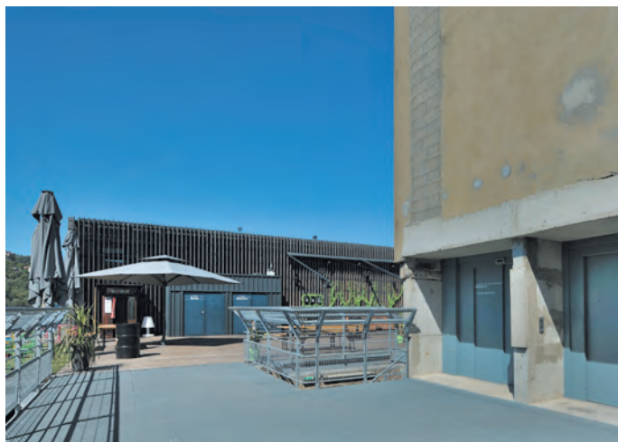
Passerelle d'accès à la terrasse depuis les ascenseurs (niveau + 4)
