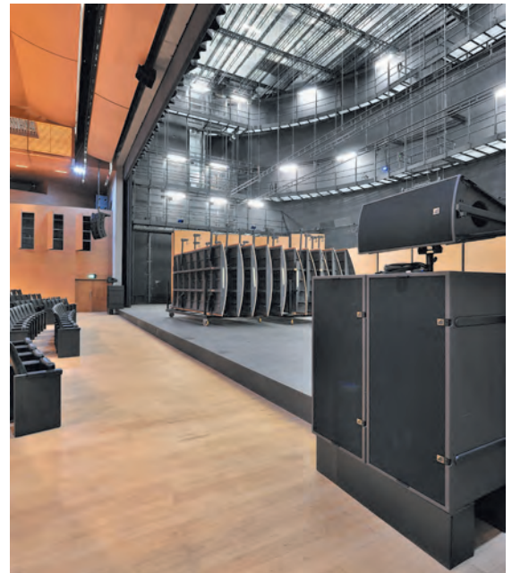
Cadre de scène, 2 enceintes L-Acoustics SB28 et une L-Acoustics Arcs Wide, plafonds de la conque sur chariots
