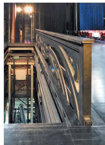
Élévateur de l'avant-scène trappes ouvertes, 1 trappe de décor volumétrique sortie
