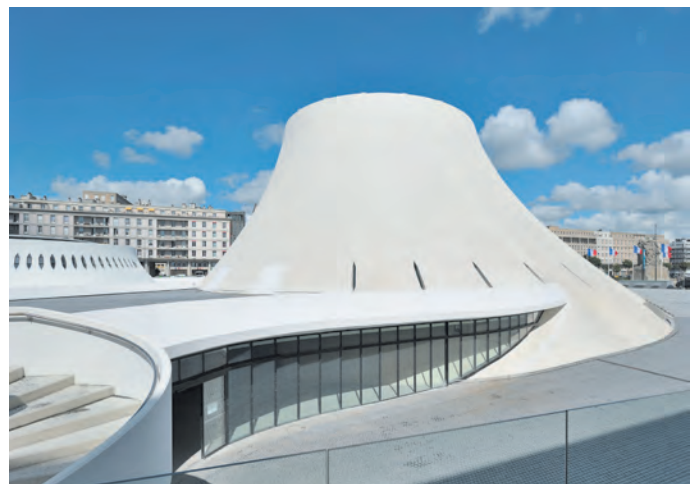
Grand Volcan, passage couvert, accès public remanié
