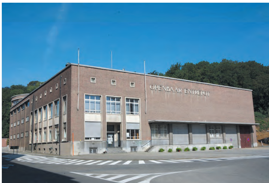
Vue extérieure générale - Photo © t'Jonck-Nilis
