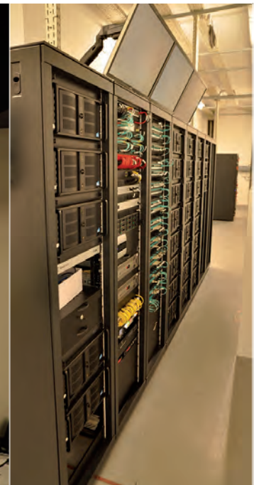
La salle des serveurs Photo © Ludovic Bouaud
