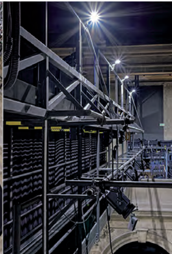
Passerelle de face sur 2 niveaux
