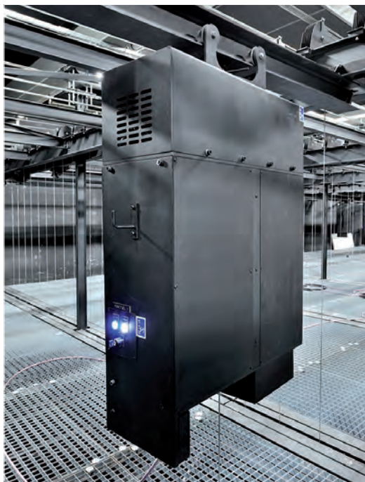
Treuil ponctuel mobile sur poutrelle AMG Féchoz
