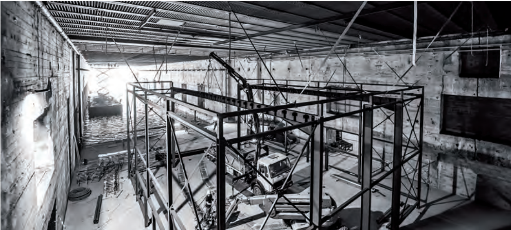
Base sous marine durant les travaux d'aménagement - Photo © Culturespaces - Anaka Photographie
