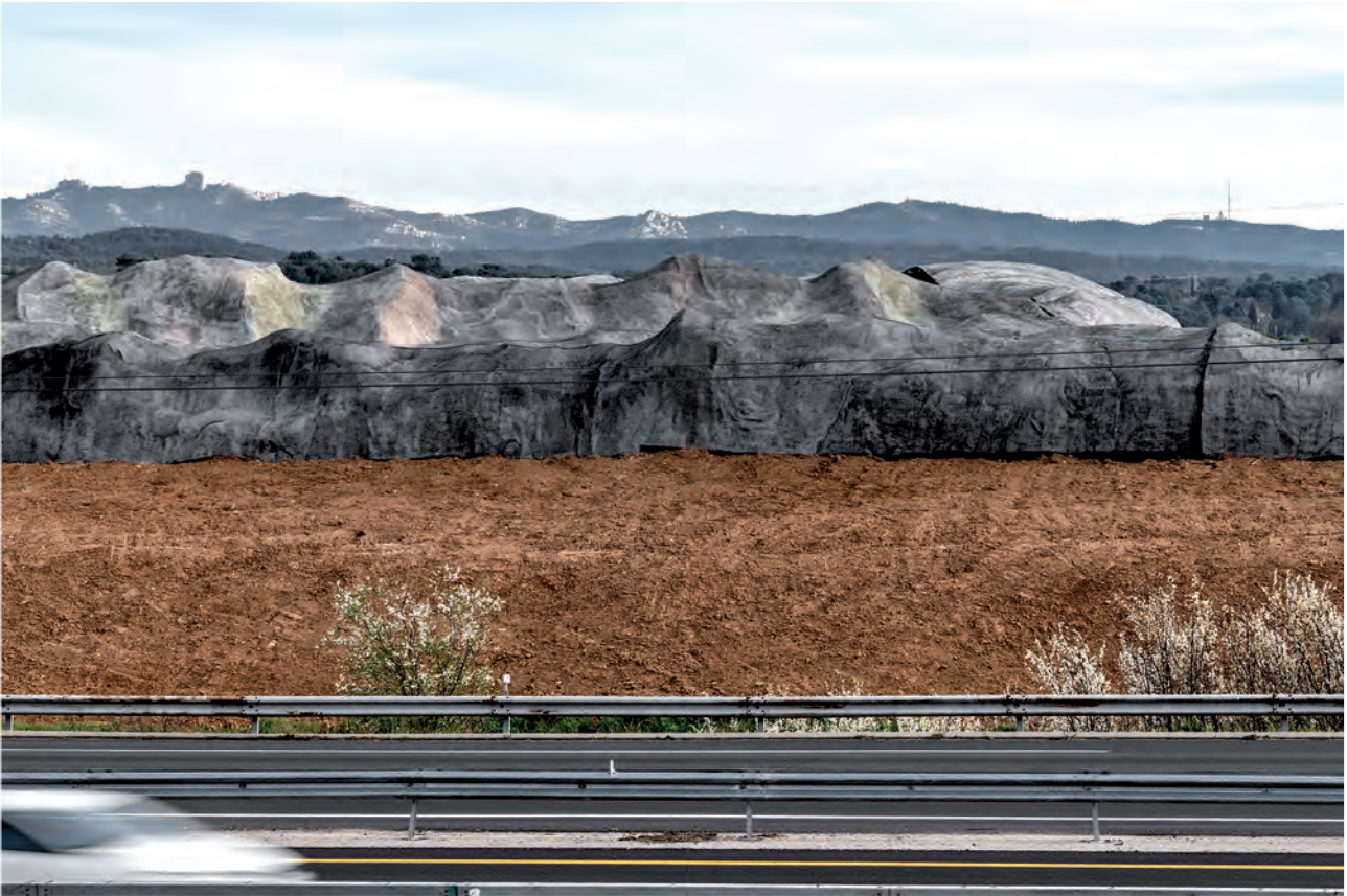
Peau en béton ouvragé, façade Nord - Photo © Lisa Ricciotti
