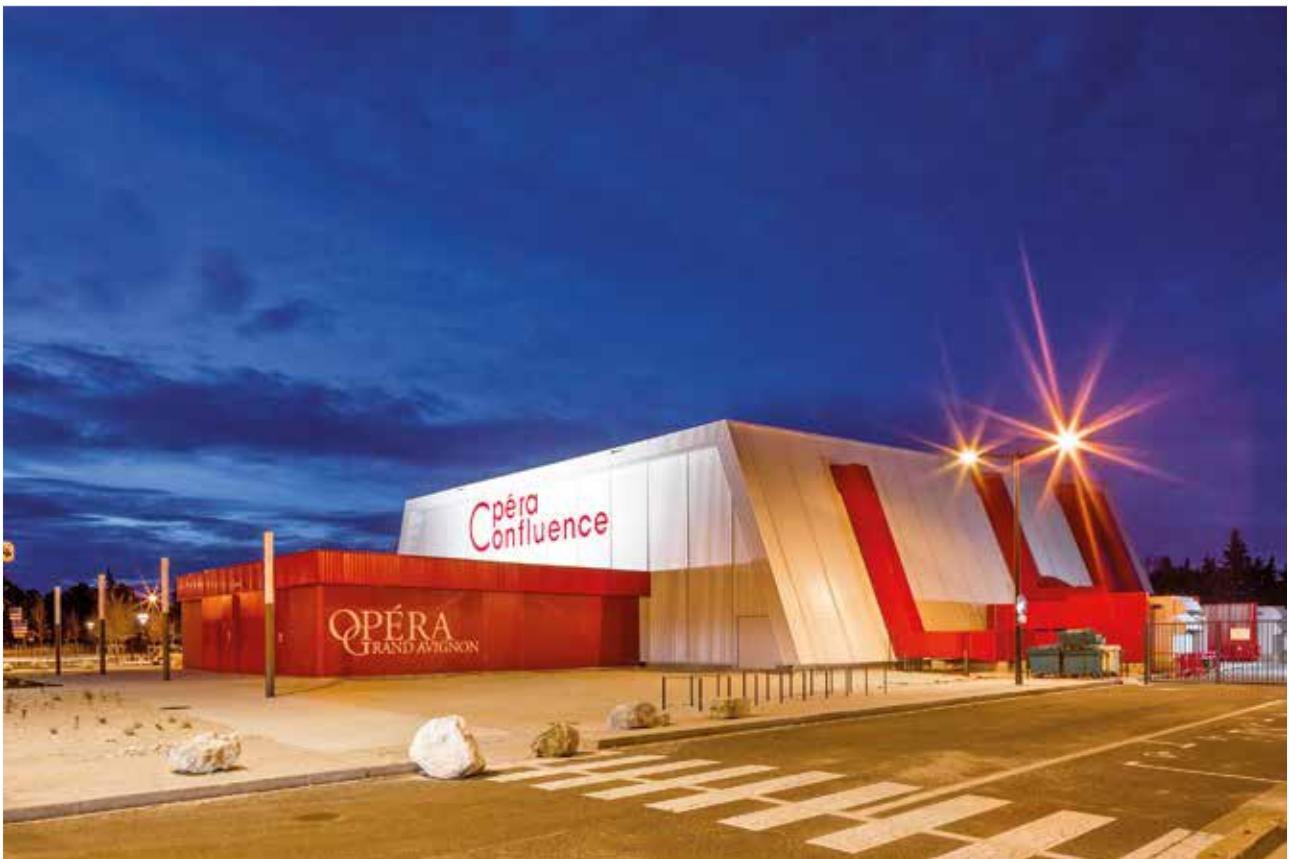
Vue extérieure de l'Opéra éphémère du Grand Avignon - Photo © DE-SO
