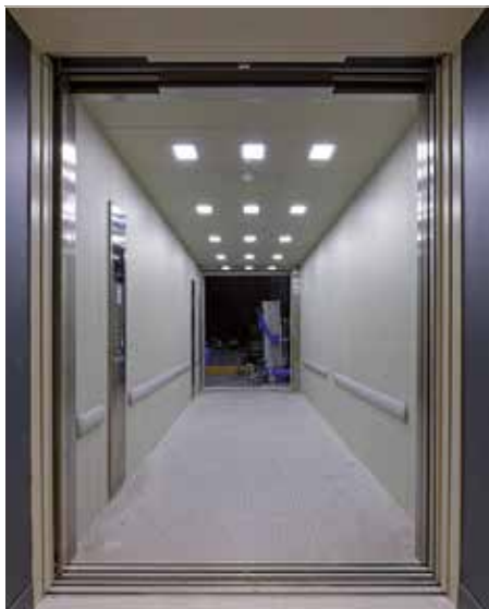
Ascenseur monte-charge de la cage de scène
