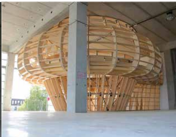
Coraulis en chantier : membrures en bois - Photo © ENSA Nantes
