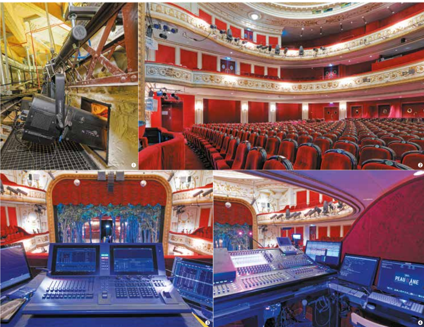
❶ Assise de la coupole, ouïes d'éclairage de face ❷ Éclairage de salle ❸ Poste de régie lumière en salle ❹ Poste de régie son en salle
