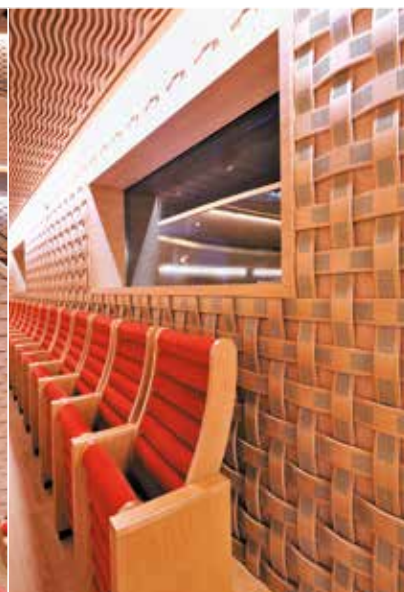
Traitement absorbant au niveau des parois de régies
