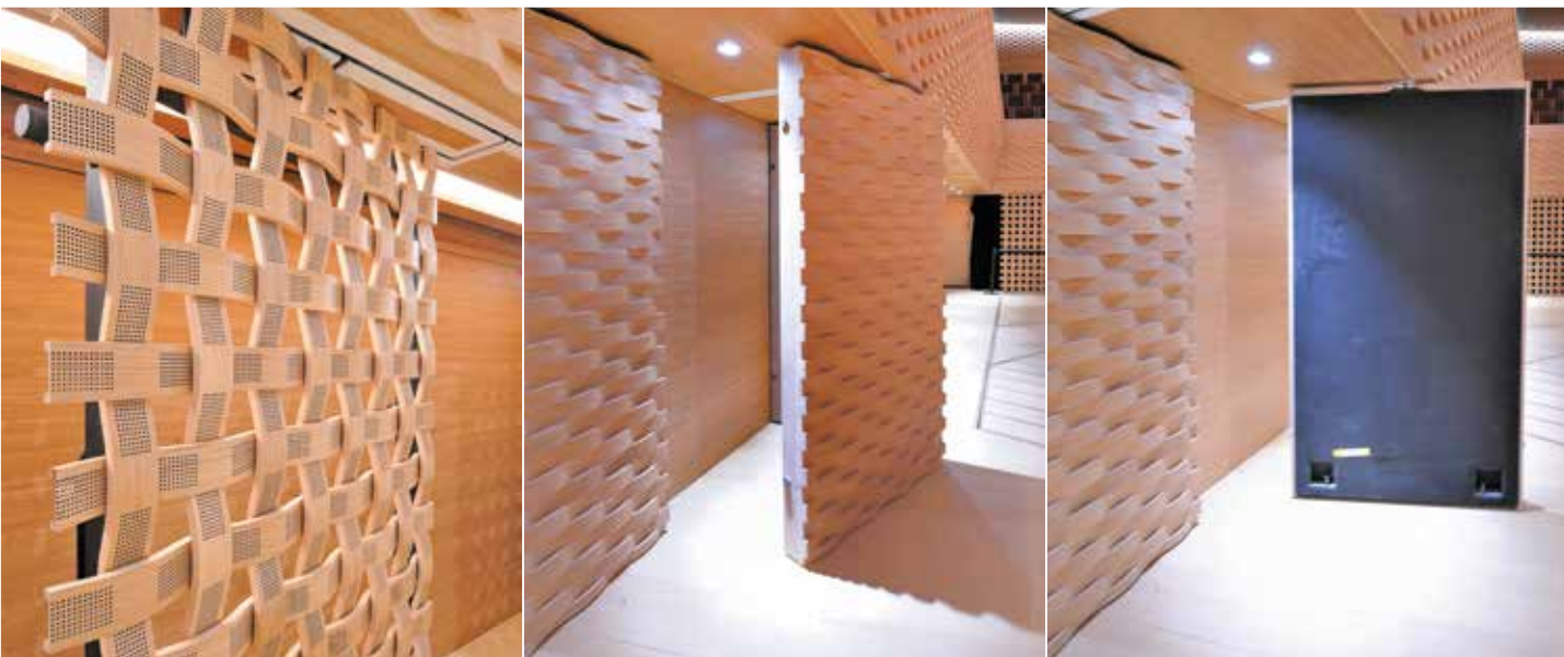
Claustra mobile du lointain
