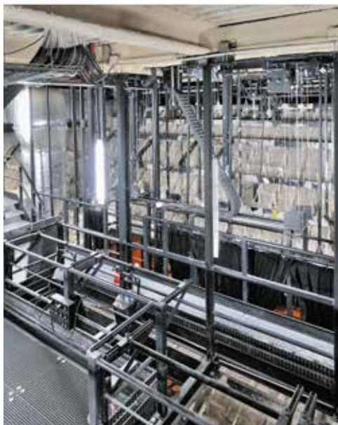
Passerelles fixes du lointain (auditorium)
