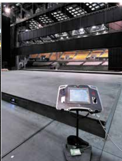
Pupitre de machinerie, wagons de décors autonomes
