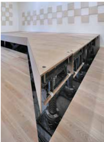
Plates-formes élévatrices (salles de répétition MHS) Gradin d'orchestre mécanisé (salle MHS)
