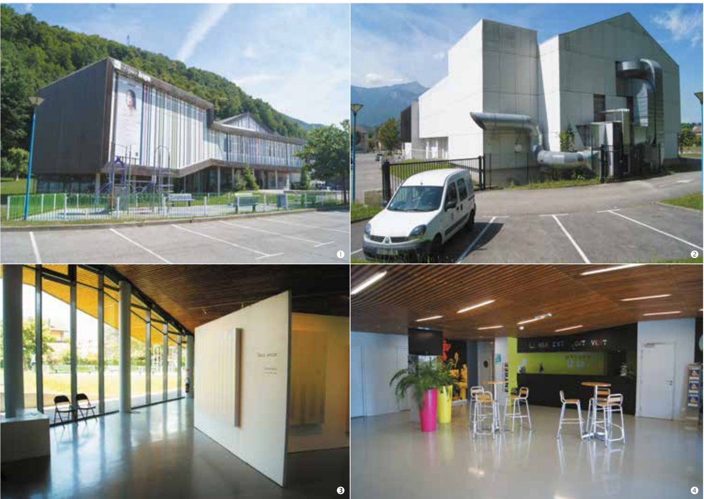
❶ Vue de la façade, côté rue ❷ Vue de la pompe géothermique qui assure une partie du chauffage et du refroidissement du bâtiment ❸ Vue de la salle d'exposition ❹ Vue du hall
