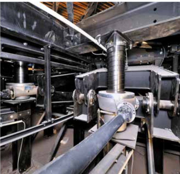
Détail d'une colonne de poussée, gradin d'orchestre
