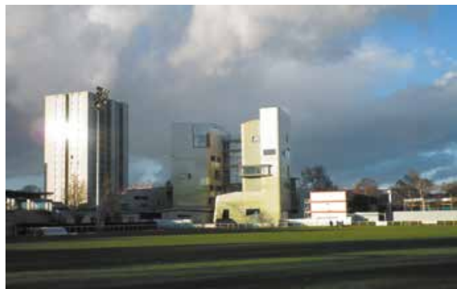
Façade sud au niveau du stade municipal - Photo © Agence FCLP
