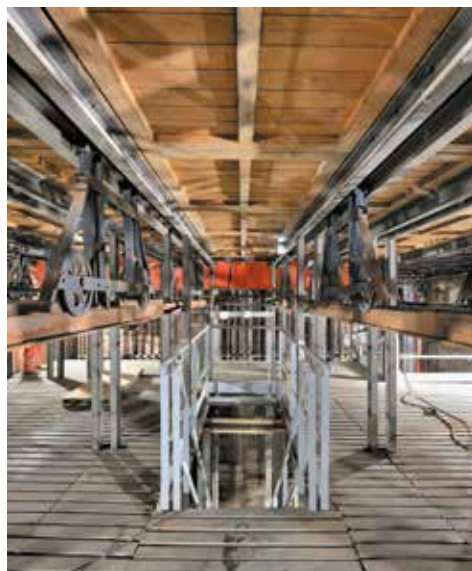
1 er dessous de scène avec ses chariots de costières, escalier d'accès au 2° dessous
