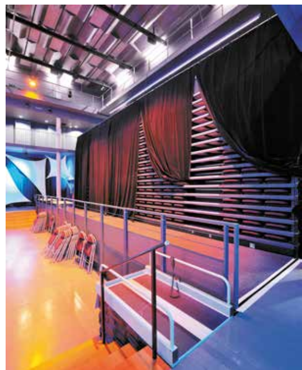
Gradin télescopique, élévateur PMR au niveau de la fosse
