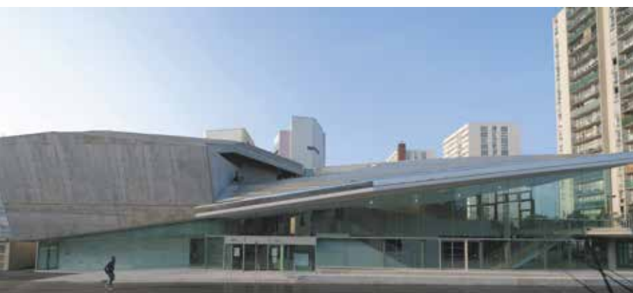
Façade commune nord - Photo © Augusto Da Silva
