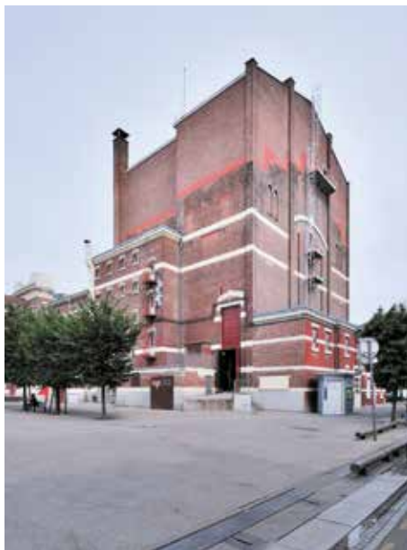
Accès décor au niveau du parvis & cage de scène
