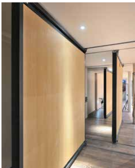
Châssis mobiles latéraux réversibles guidés
