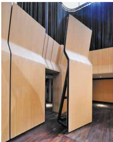
Châssis mobiles de fond de scène, structure calquée sur le galbe du garde-corps supérieur
