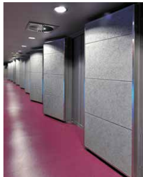
Panneaux acoustiques réversibles en 2 e galerie
