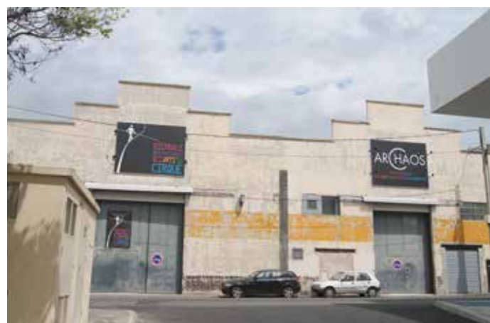
Vue extérieure des bâtiments d'Archaos
