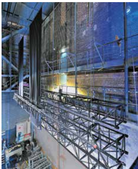
Stockage vertical au-dessus du dégagement à l'arrière-scène
