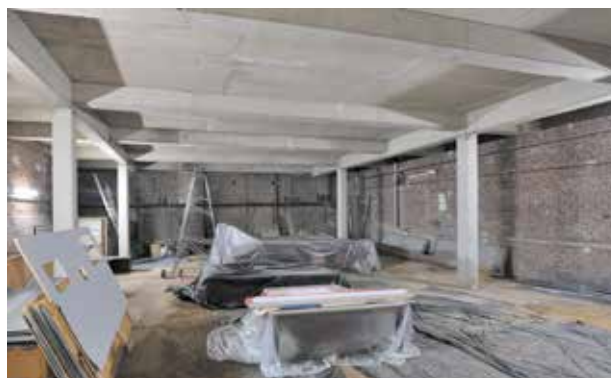
La nouvelle dalle séparant définitivement le nouveau 1 er dessous des anciens 2 e et 3 e dessous, coulée sur sa structure en tabouret
