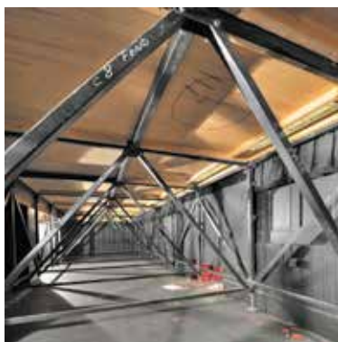
La fosse d'orchestre et la structure porteuse des trappes du plancher de l'avant-scène
