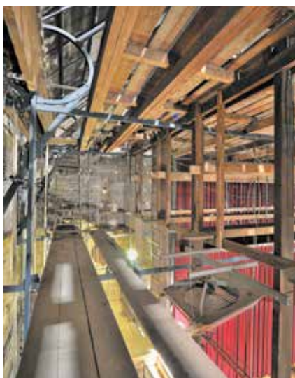
La plate-forme d'accès aux ponts de singes côté cour, située au-dessus de la passerelle latérale
