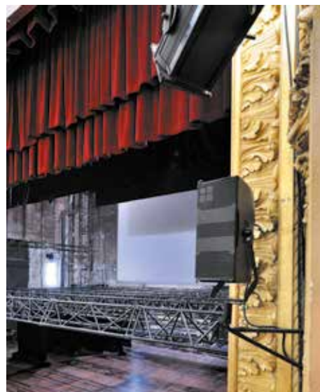
La diffusion au cadre de scène d&b audiotechnik Ti10P sur lyres orientables destinée aux balcons
