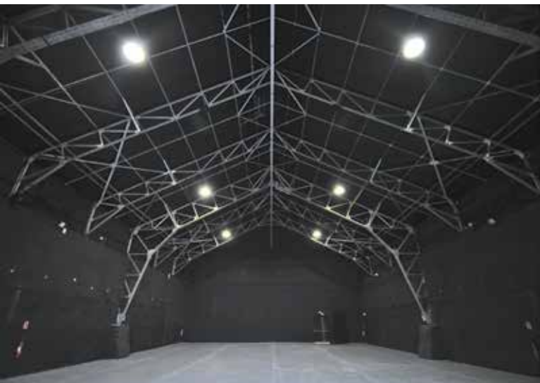
Vue de la grande halle de travail - Photo © Le Fourneau
