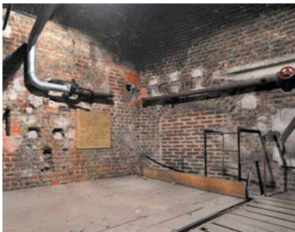
L'ancien réservoir d'incendie sous les voûtes du parterre de salle
