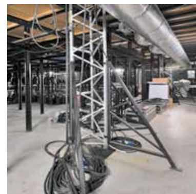
Une tour de levage Stacco fixée à la dalle du 1 er dessous à l'aide de chevilles chimiques
