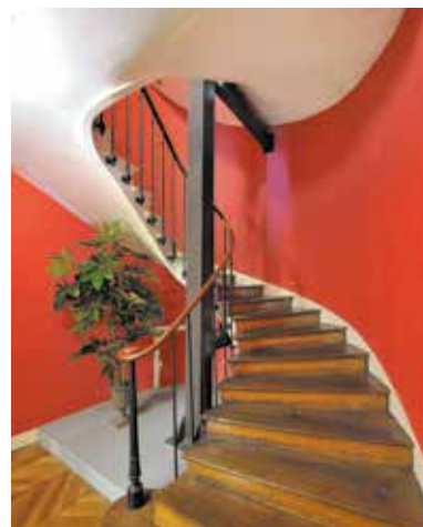
Escalier d'accès aux promenoirs rénovés avec renforcement de la structure en bois
