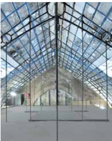
Le plafond de salle et la toiture du théâtre entièrement restaurée
