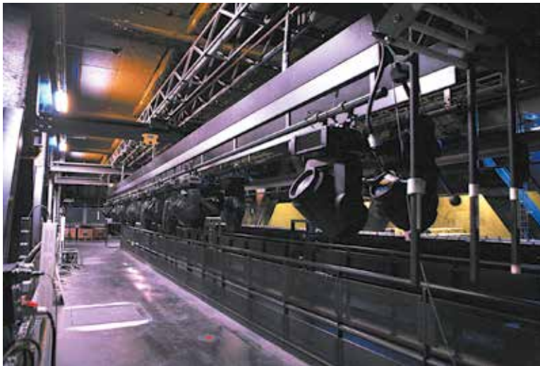
Une galerie de travail au-dessus des trappes du plafond
