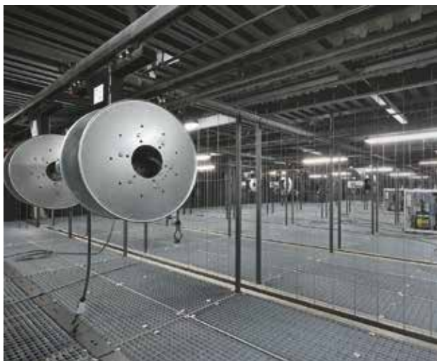
Vue d'ensemble du gril de marche et de ses équipements
