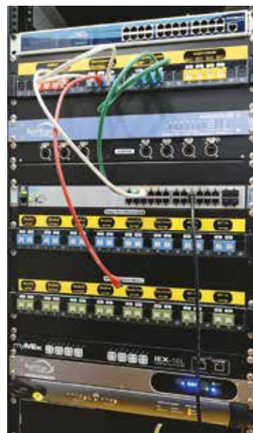
Nodal scénique en cabine d'enregistrement, interfaces de haut en bas : AvuTran AVM500, myMix IEX-16L, AvuTran AVBx3, Avid Pro Tools | HD MADI (pôle création)
