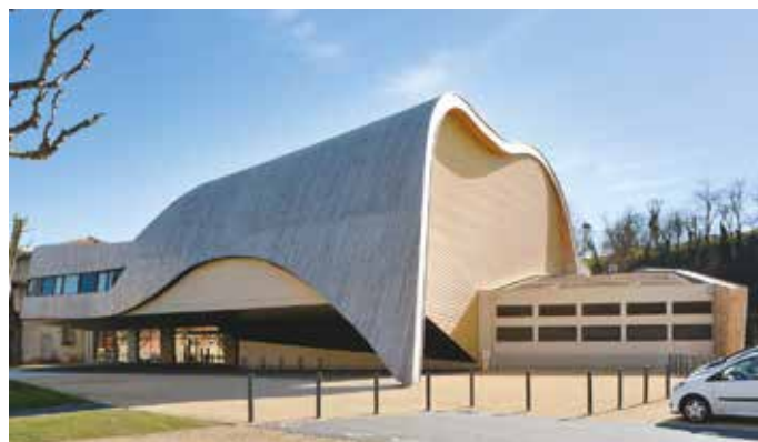
Ligne du soubassement au niveau du porte-à-faux du gradin, locaux administratifs (à gauche), locaux de services (à droite) - Photo © Studio Erick SAILLET
