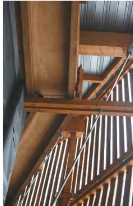
Dans la volige, des tendeurs permettent de soutenir une partie et de réduire la portée des poutres Photo © François Delotte
