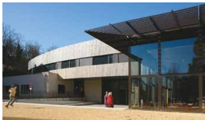
Façade Est, entrée indépendante de la Cordonnerie, cafétéria (à droite) Photo © Studio Erick SAILLET
