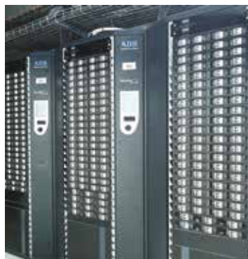
Baies de gradateurs ADB Stand Alone Eurodim Twin Tech (grande salle)
