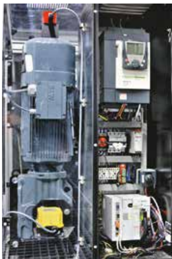
Treuil ponctuel mobile Tambè CEMS, motorisation (à gauche), variateur de vitesse et son électronique de contrôle de l'axe (à droite)
