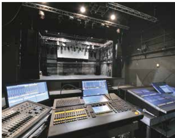
Postes de régies en salle (La Cordonnerie)
