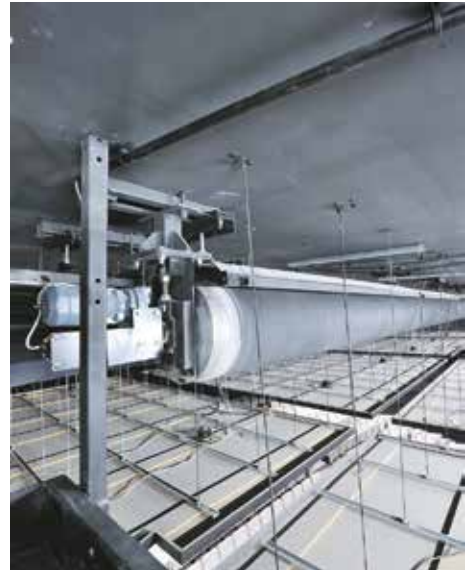
Tambours motorisés du dispositif de réduction de jauge (grande salle)
