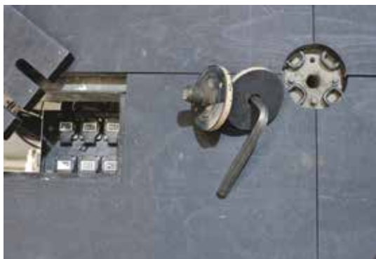
Boîtiers des circuits gradués réservés à la lumière, ancrage circassien vissé sur platine de verrouillage (en tête de poteaux de la structure de scène)
