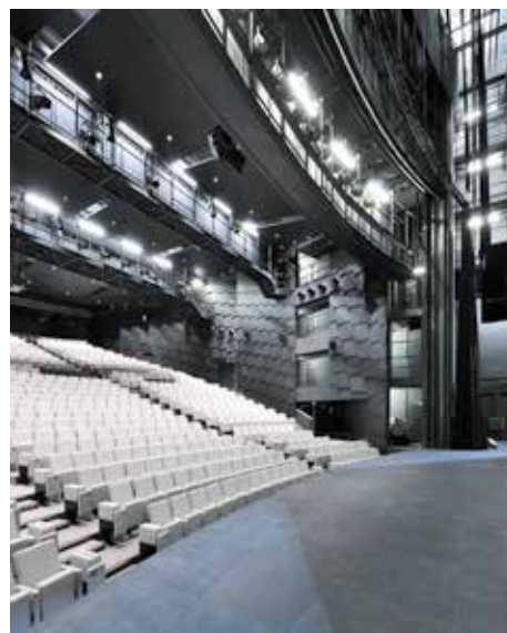
Cadre de scène et en haut, le pont lumière et les passerelles
