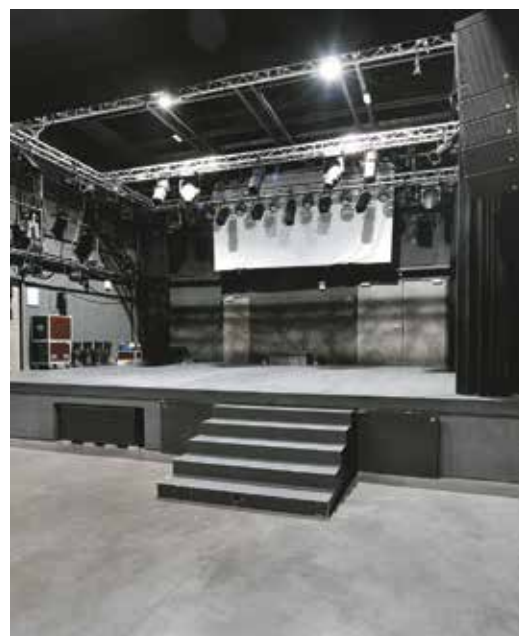
La scène avec le renfort de graves et son emplacement sous la scène, l'escalier escamotable d'accès à la scène (La Cordonnerie)
