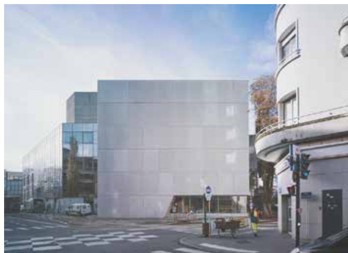
Nouvelle construction façade Nord - Photo © J. Lanoo
