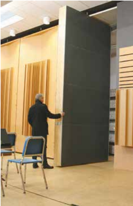
Derrière le chef d'orchestre, une paroi pivotante est composée d'une face réfléchissante et d'une face absorbante Photo © François Delotte
