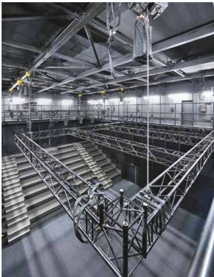
Les truss de scène installés dans la salle de création
