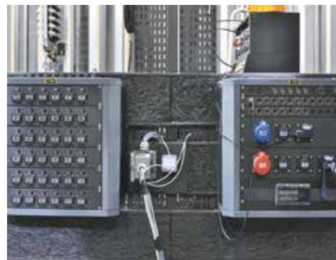
Armoires de scène des réseaux scéniques
