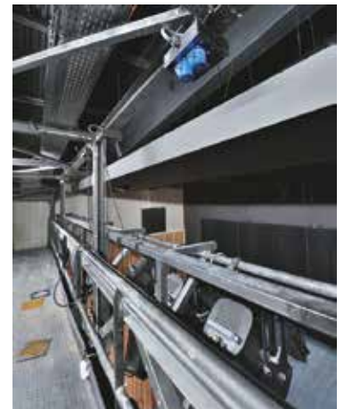
Détails de la passerelle transversale de salle, lisses pour projecteurs, projecteurs accessibles à travers des membrures de la ferme américaine de la passerelle (auditorium)
