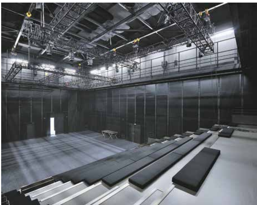
Gratin télescopique déployé et plafond technique (salle de création)
