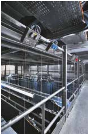
Passerelle périmétrique partielle de scène, boîtiers réseaux scéniques à hauteur des yeux (auditorium)
