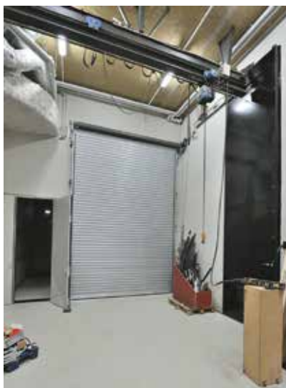
Aire de manutention avec de gauche à droite : accès vers la salle de création, porte du monte-charge & fente d'accès décor
