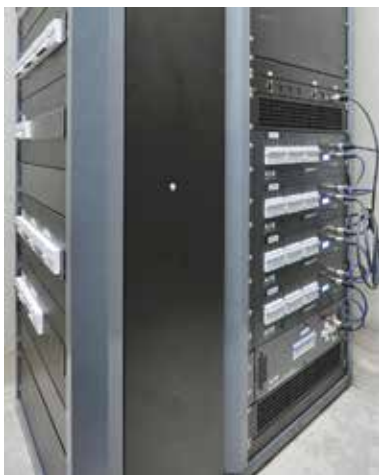
TGBT scénique, gradateurs 3 kW et 5 kW ADB Mikapack 30 (auditorium)
