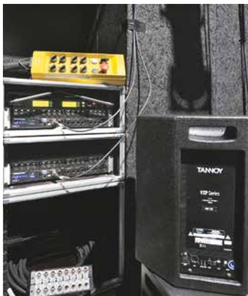
Télécommande des 4 palans électriques du truss de scène, convertisseurs audionumériques AvuTran ABVx7, retours de scène Tannoy WXP Series 12Q (La Cordonnerie)
