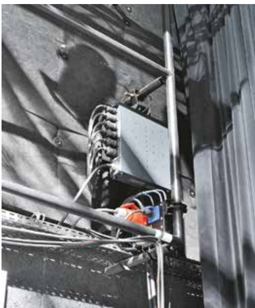
Réseau de lisses tubulaires de scène, gradateur mobile en place, un boîtier de connexion locale en direction des réseaux scéniques lumineux (La Cordonnerie)
