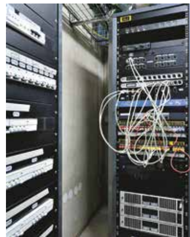
Nodal scénique, interface AvuTran AVM500 distribuant le réseau général EtherSound, amplis Lab.gruppen Installation C Series C88-4 et C 68-4 (La Cordonnerie)
