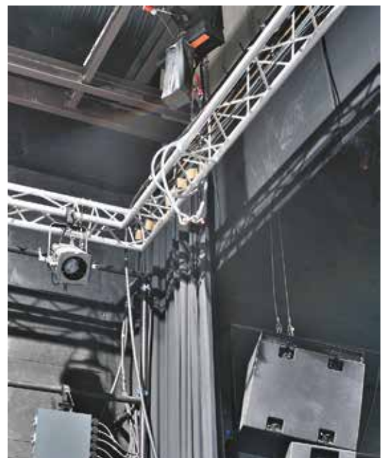
Détails au niveau du cadre : palan électrique du truss mobile de scène, cluster de diffusion de façade sur élingues fixes doublées (La Cordonnerie)
