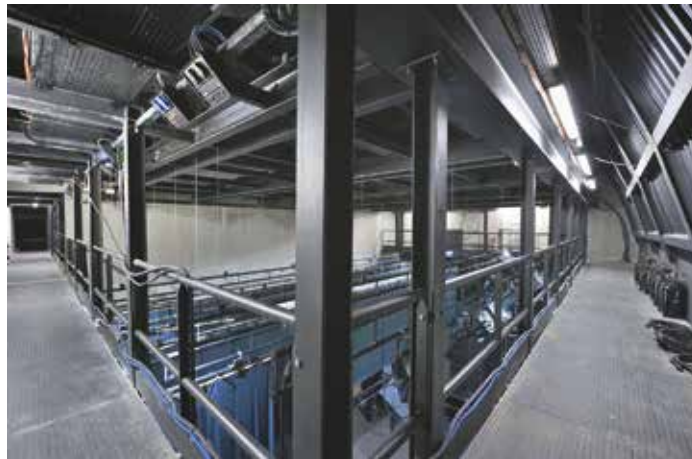
Vue d'ensemble, gril de charge au niveau de la passerelle périmétrique partielle (auditorium)
